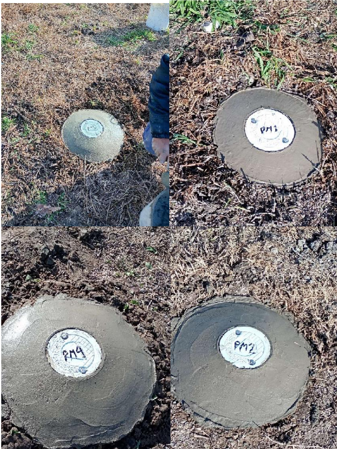
Fotografías: terminación de boca de pozo con caja vereda
